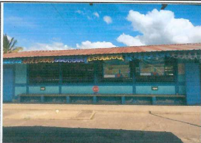
Foto 1. MEJORAMIENTO DE ESTRUCTURA TECHO TIPO PORTICO
